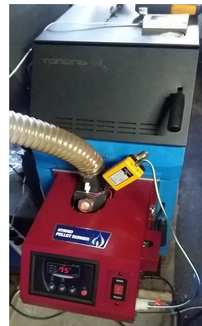
Пример - Горелка KRPB-20A в котле ZOTA Тополь- М 30 кВт
